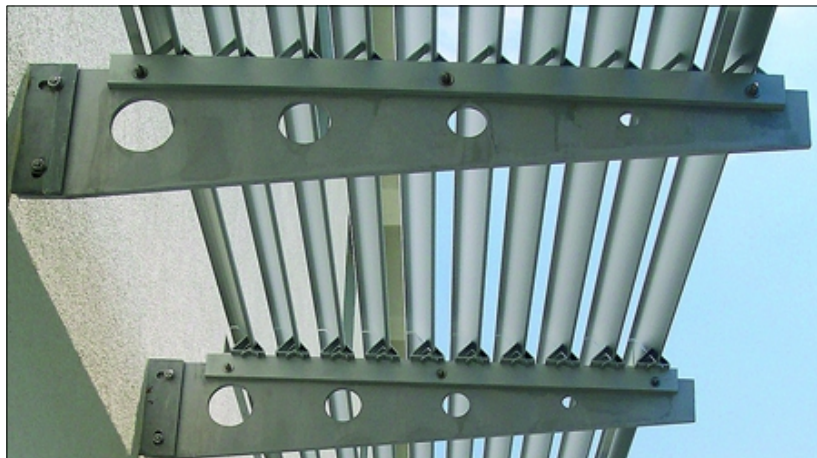
Niet alleen de lengte van de lamel speelt een rol bij de berekening van de windbelasting bij horizontale systemen, ook de uitkraging is van cruciaal belang
