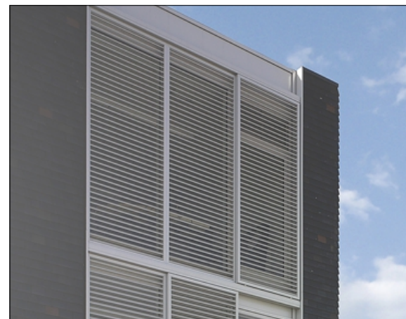
Schuifpanelen kunnen manueel of eventueel motorisch opzij geschoven worden
