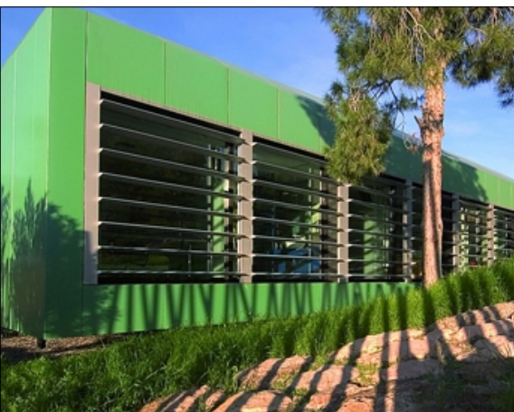
Het verticale systeem met lamellen kan bij een laagstaande zon toch nog veel licht tegenhouden
