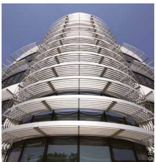
De buitenzonwering kan het gevelbeeld domineren.
