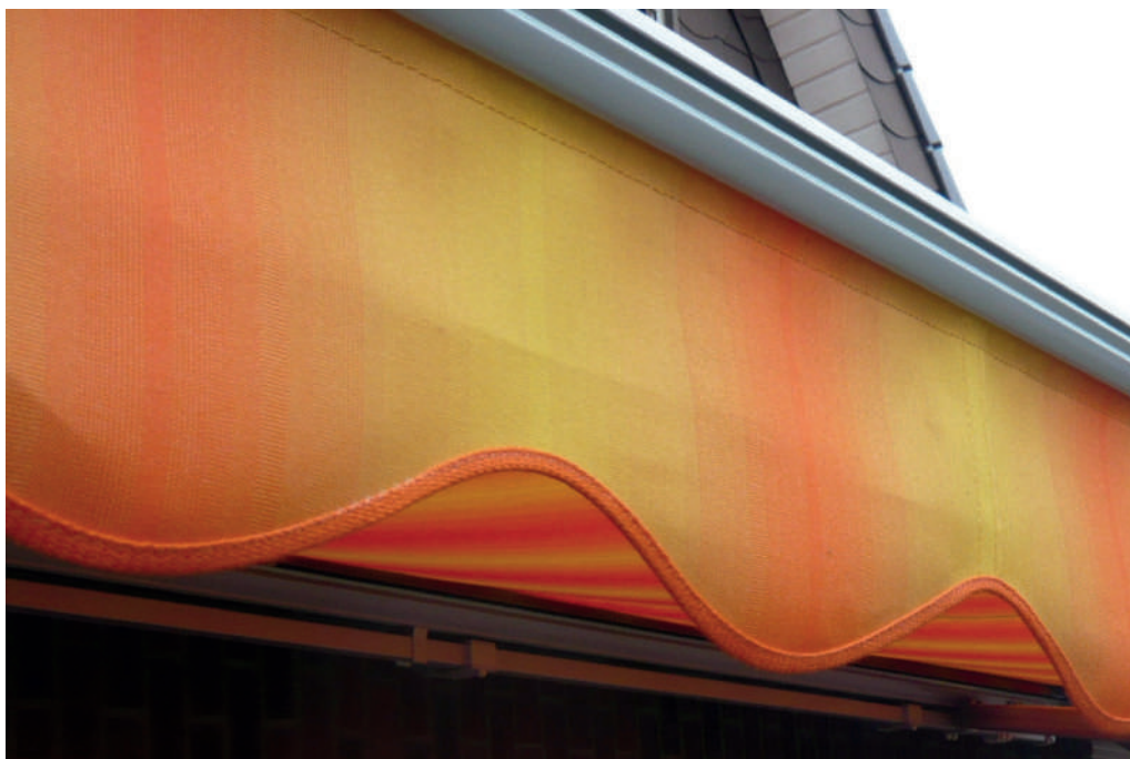
Illustration 9.1.19 - Formation de plis admissibles dus à l'emballage dans la zone du volant
