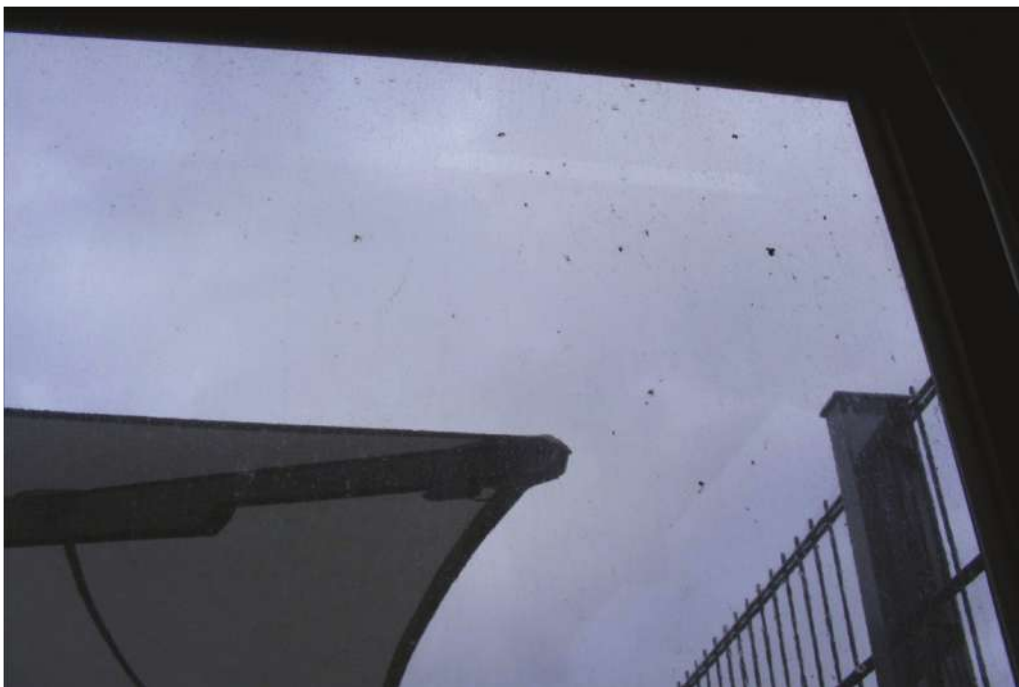
Illustration 9.4.5 - Traces de frottement et de griffures pouvant se former dans la fenêtre transparente en PVC
