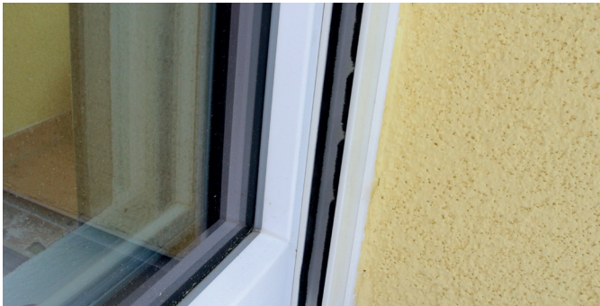
Afbeelding 24: De geleiders zijn op sommige plaatsen zo erg ingedeukt dat ze hun oorspronkelijke vorm niet meer terugkrijgen.
