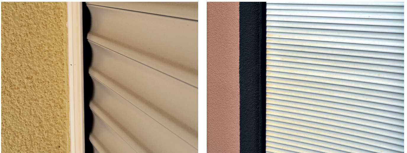
Afbeelding 28 + 29: Afzettingen van stof, pollen en andere milieu-invloeden die in de loop der tijd op het oppervlak van de staafjes zijn gebrand.
