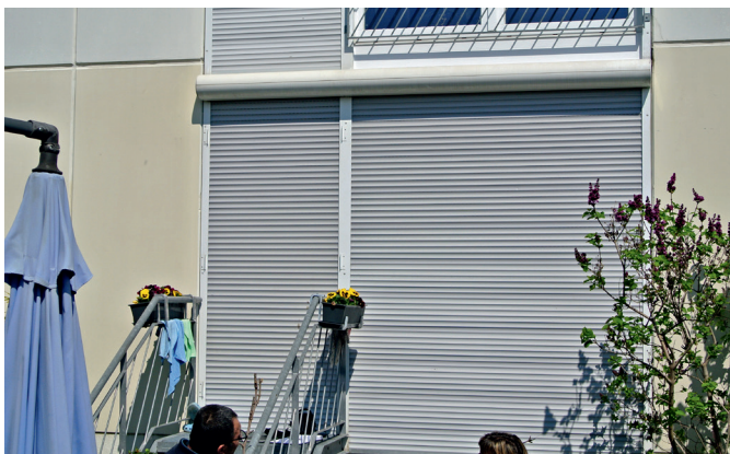
Afbeelding 22+23: golvend rolluikblad.
