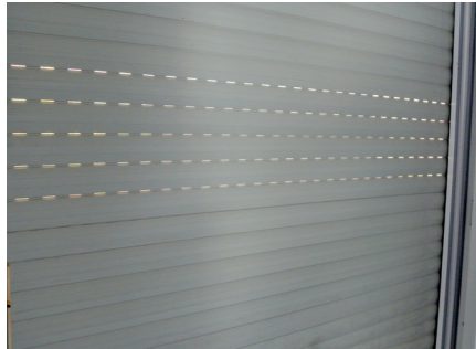
◀ Afbeeldingen 17 en 18: Rolluikblad met open lichtspelen in neergelaten positie. (Bron: Hella)
