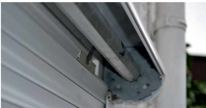
Afbeelding 26: op de bovenste lamellen zijn aftekeningen van de ophangingsveren te zien. Deze indrukkingen zijn niet te vermijden en in zoverre toegelaten.
