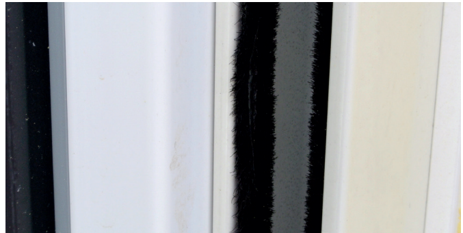
Afbeelding 25: Op sommige plekken zijn de geleiders doorgesleten en versleten.
